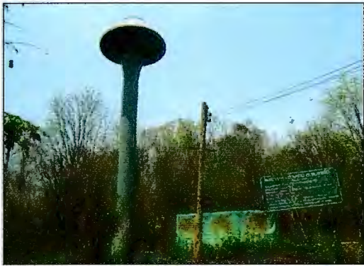
ถังพักน้ำขนาดความจุ 15 ลูกบาศก์เมตร
